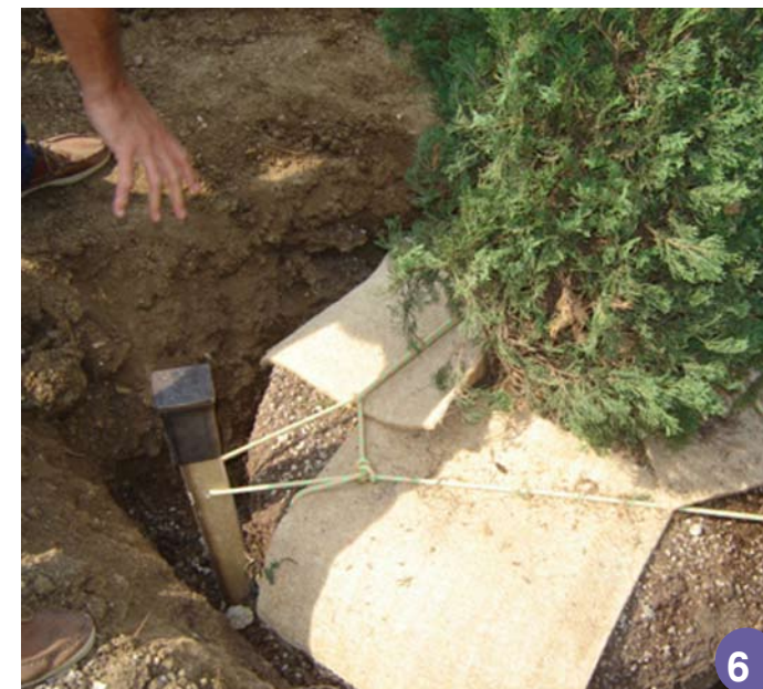
Fig. 4 Schema di posa del Fast Tutor
