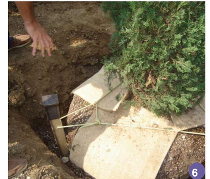
Fig. 4 Schema di posa del Fast Tutor
